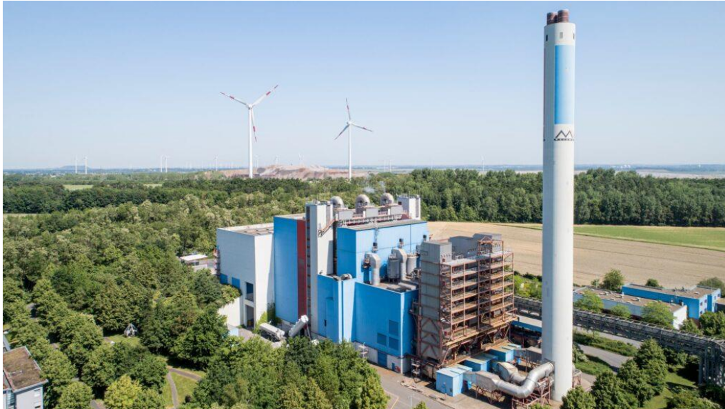
Abbildung 55: Müllverbrennungsanlage Weisweiler. Quelle: MVA Weisweiler
