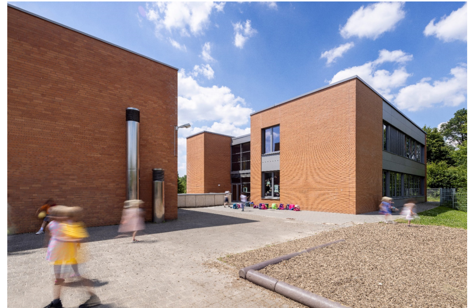
Oberer Schulhof mit Eingang Schuletage
