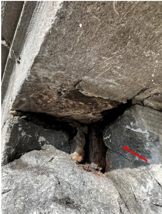
Rostende Metallteile (Dorne, Klammern, etc.)
