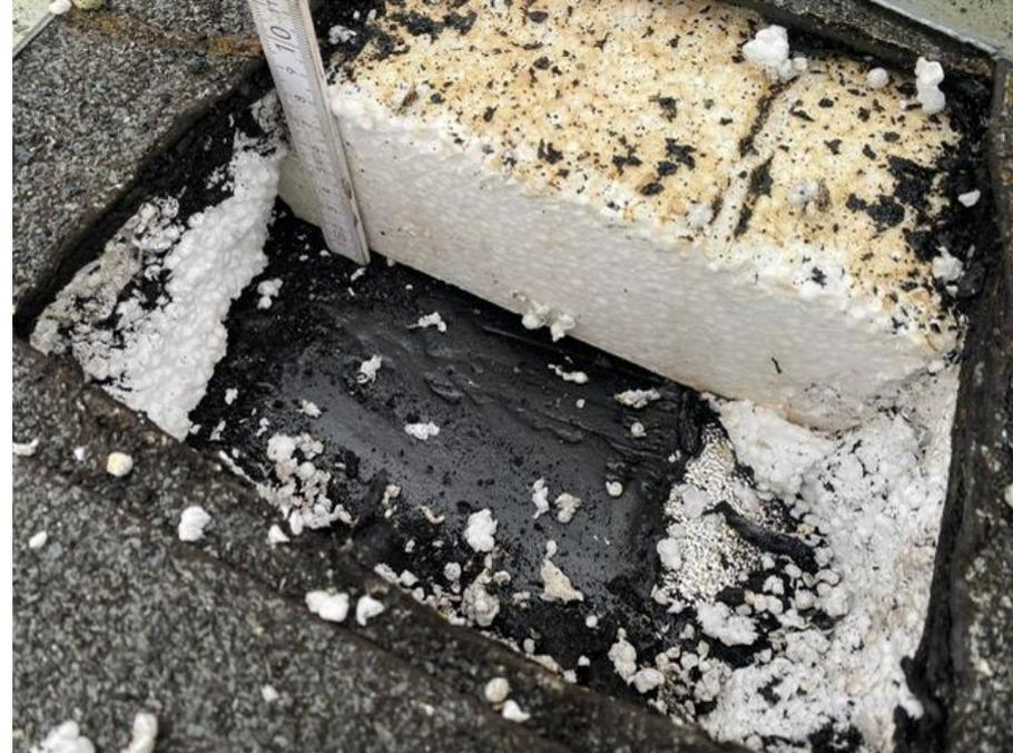
Folienlage aufgrund UV-Einwirkung flächig perforiert; Wassereintrag nicht lokalisierbar/ durch Trapezbleche Verteilung und Abtropfen in verschiedenste Bereiche der Halle
