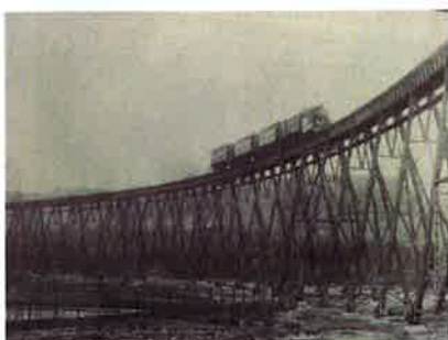
Foto 1: Viaduct over Gulpdal
