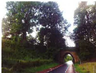
Foto 11: Viaduct over weg Reijmerstok-Euverem
