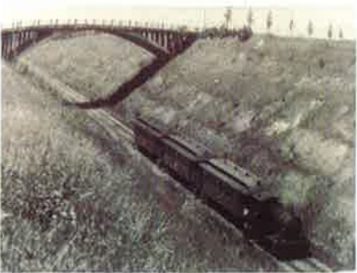
Foto 7: Brug N598 De Hut
