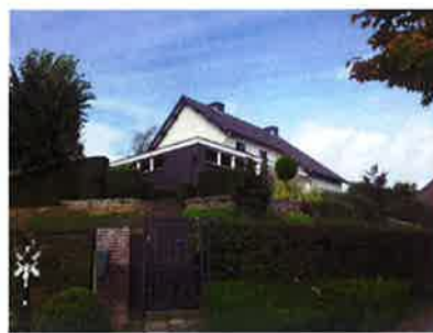
Foto 14: Woning op westelijk talud van het Gulpdalviaduct
