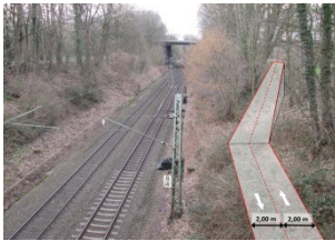
Bahnstrecke AC-D'dorf (Blickrichtung Richterich)
