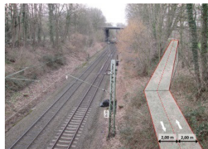
Bahnstrecke AC-D'dorf (Blickrichtung Richterich)
