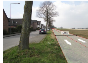
Vetschauer Weg (Höhe Am Gut Bau)
