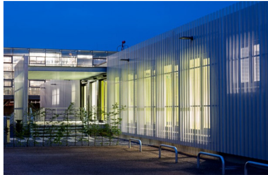
Temporäres Seminargebäude "SemiTemp"
