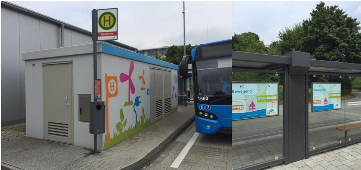
Abbildungen 3 und 4: Behausung für die verschiedenen Ladekomponenten; Leitungskanal am Warthäuschen einer Haltestelle (Quelle: stellwerk bv)
