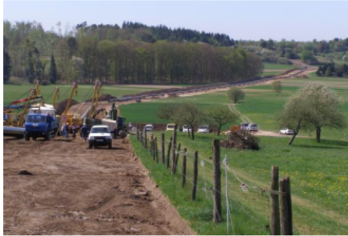
während des Leitungsbau (Quelle: OGE)
