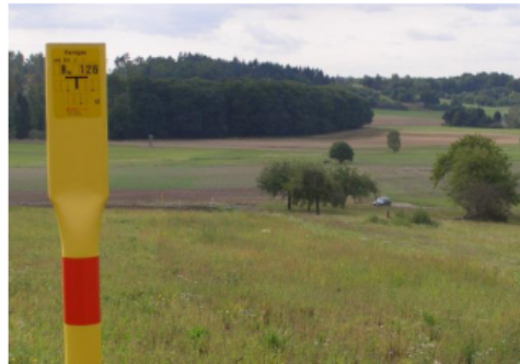
nach dem Leitungsbau (Quelle: OGE)
