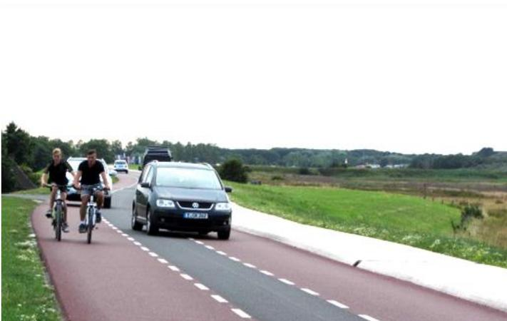
Abbildung 1: beispielhafte Fahrbahnmarkierung bei einer Rad-Vorrang-Route
