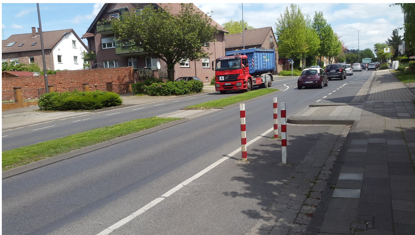
Von Coels-Straße / Haltestelle Rheingold: bestehende Querungshilfe westlich der Einmündung
