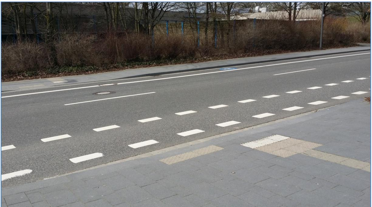
**Vorhandene taktile Elemente und Nullabsenkungen für einen barrierefreien Übergang**
