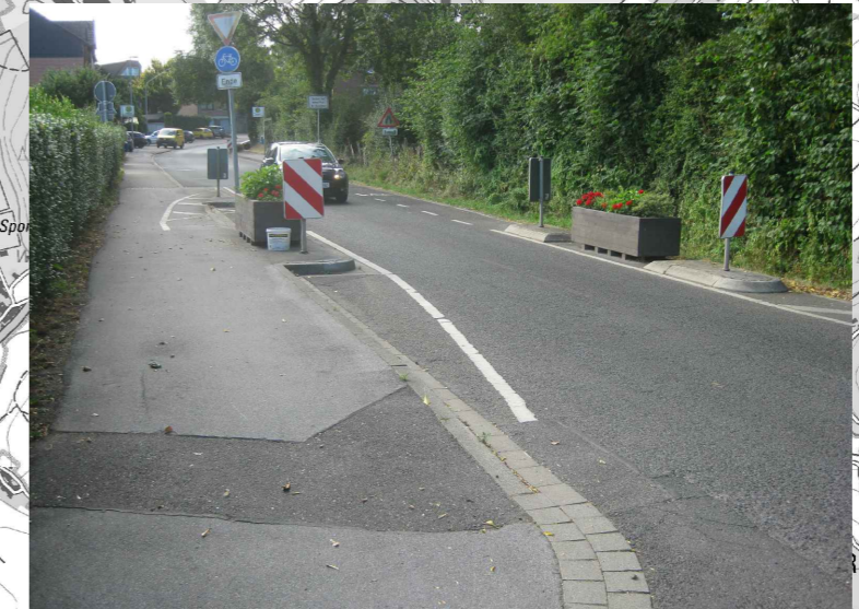
Bild B: Fahrbahnverengung Dorff K14
