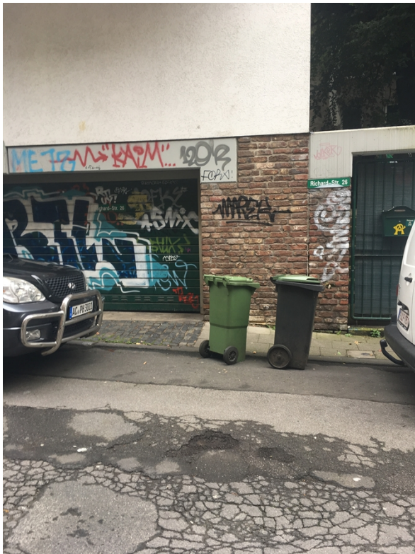
Abb.3: Mitte Richardstraße; Fahrbahndecke vor Einfahrten
