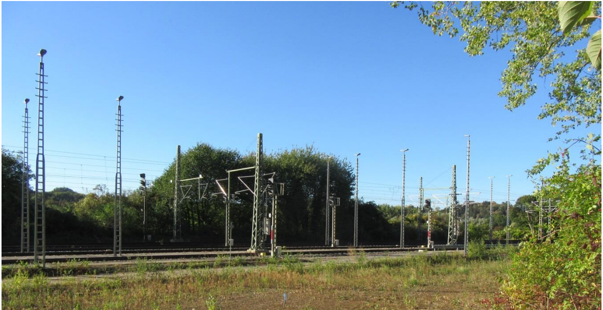
Abbildung 3: Blick von der Ostseite der Gleise Richtung Westen
