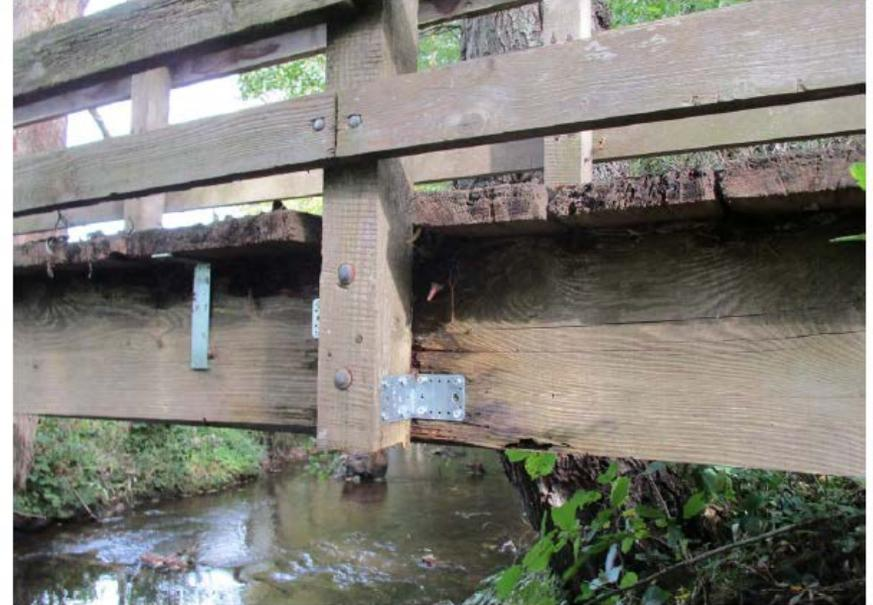
**Befund:** die Brückenaufleger aus Holz sind irreparabel angefault.
