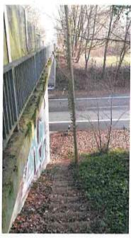
Da diese Lärmschutzwand im Bereich der Überführung des Luhrweges über die L 232 unterbrochen wird, sind auf dem Überführungsbauwerk Luhrweg noch auf einigen Metern Schallschutzelement aus Glas aufmontiert.
