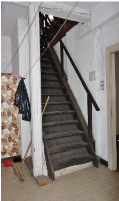
Dachgeschoss Zugang zum Spitzboden/Speicher
