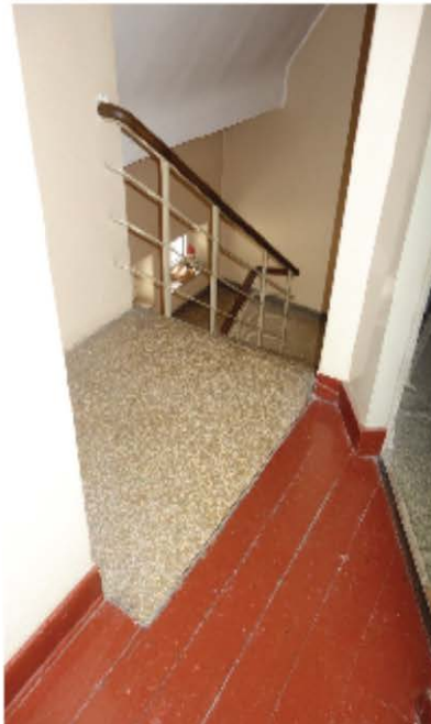
Treppenhaus Zugang Dachgeschoss
