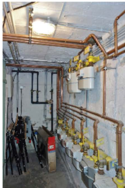
Keller Gaszählerplatz/Hausanschluss
