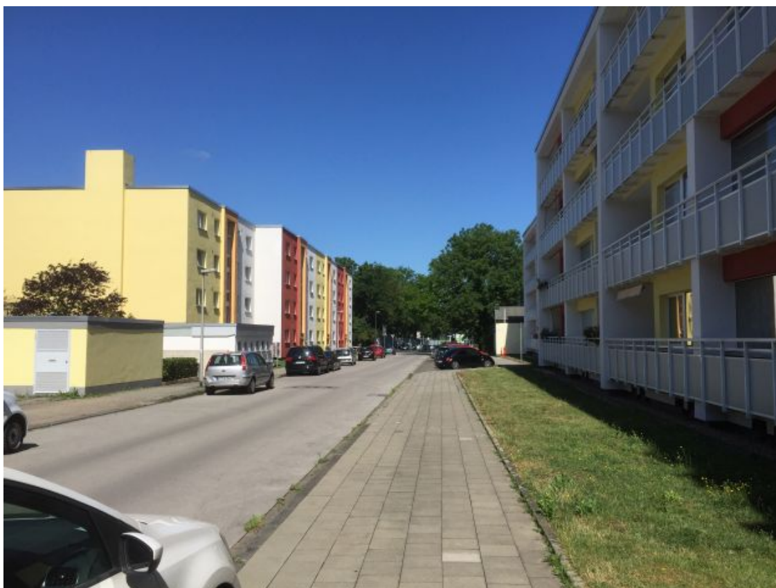
Mehrgeschosswohnungsbau in der Paul-Röntgen-Straße
