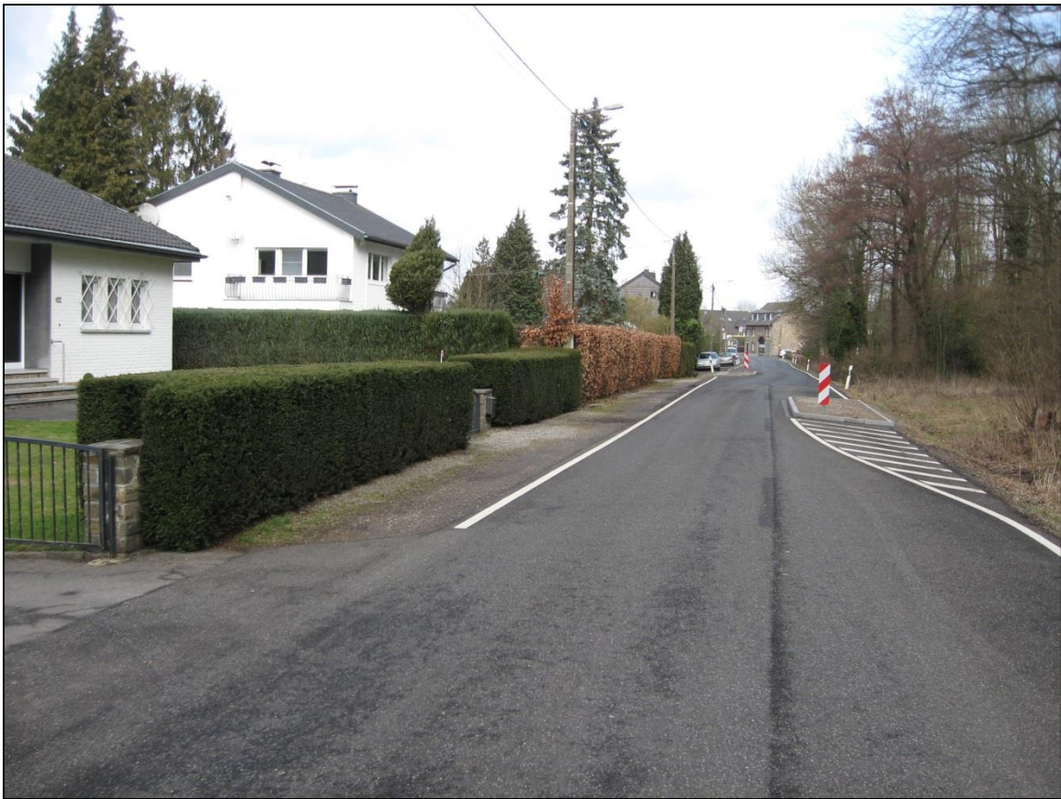
Beispiel Fahrbahneinengung durch versetzte Verkehrsinseln
