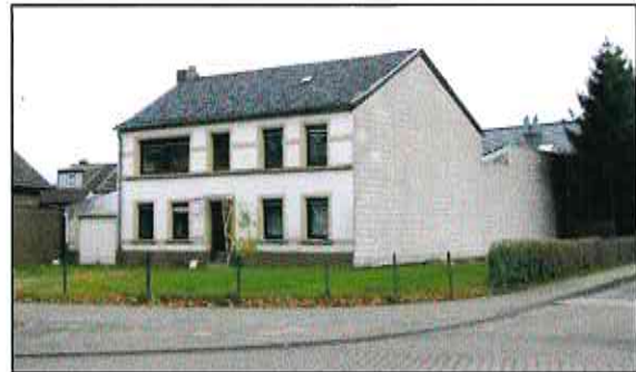
Abbildung 9: Leer stehendes Einfamilienhaus in der Ringstraße
