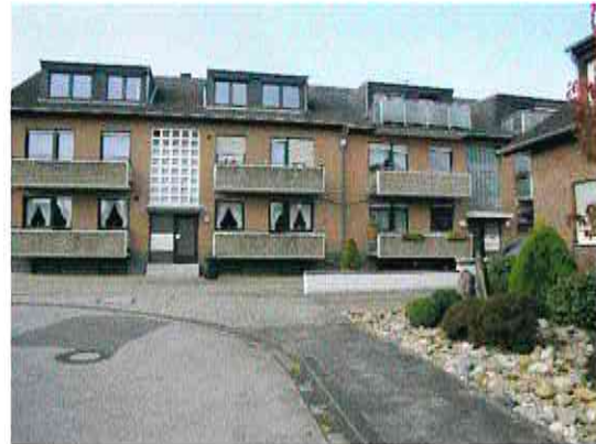
Abbildung 14: kleines Mehrfamilienhaus in der Schroufstraße.
