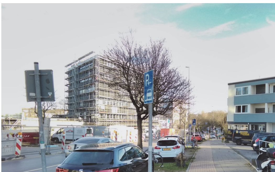
Abbildung 4: Baustelle in der Hohenstaufenallee
