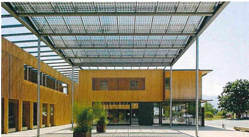
Beispiel Photovoltaikmodule: Gemeindezentrum Ludesch
