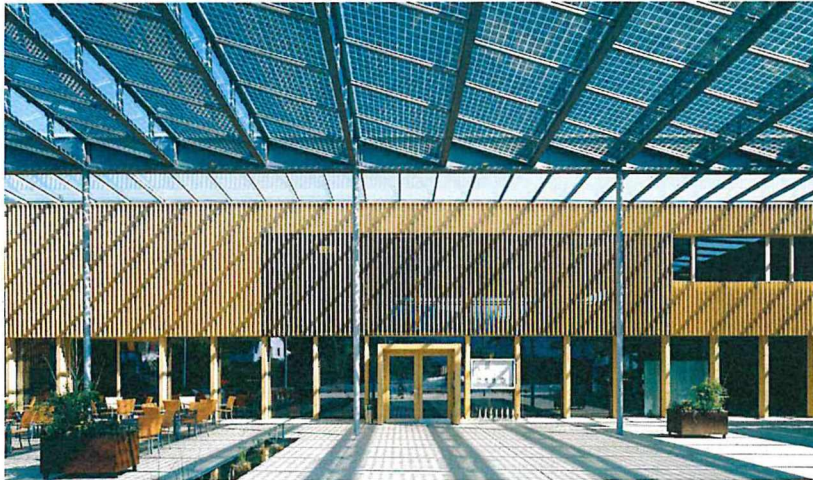
Beispiel Photovoltaikmodule: Gemeindezentrum Ludesch
