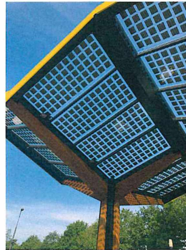
Beispiel Photovoltaikmodule: Ladestation Eindhoven
