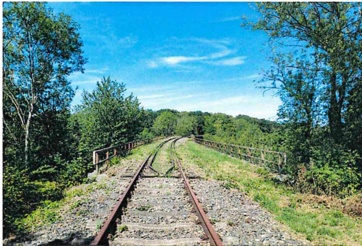
Blick auf das Falkenbachviadukt
