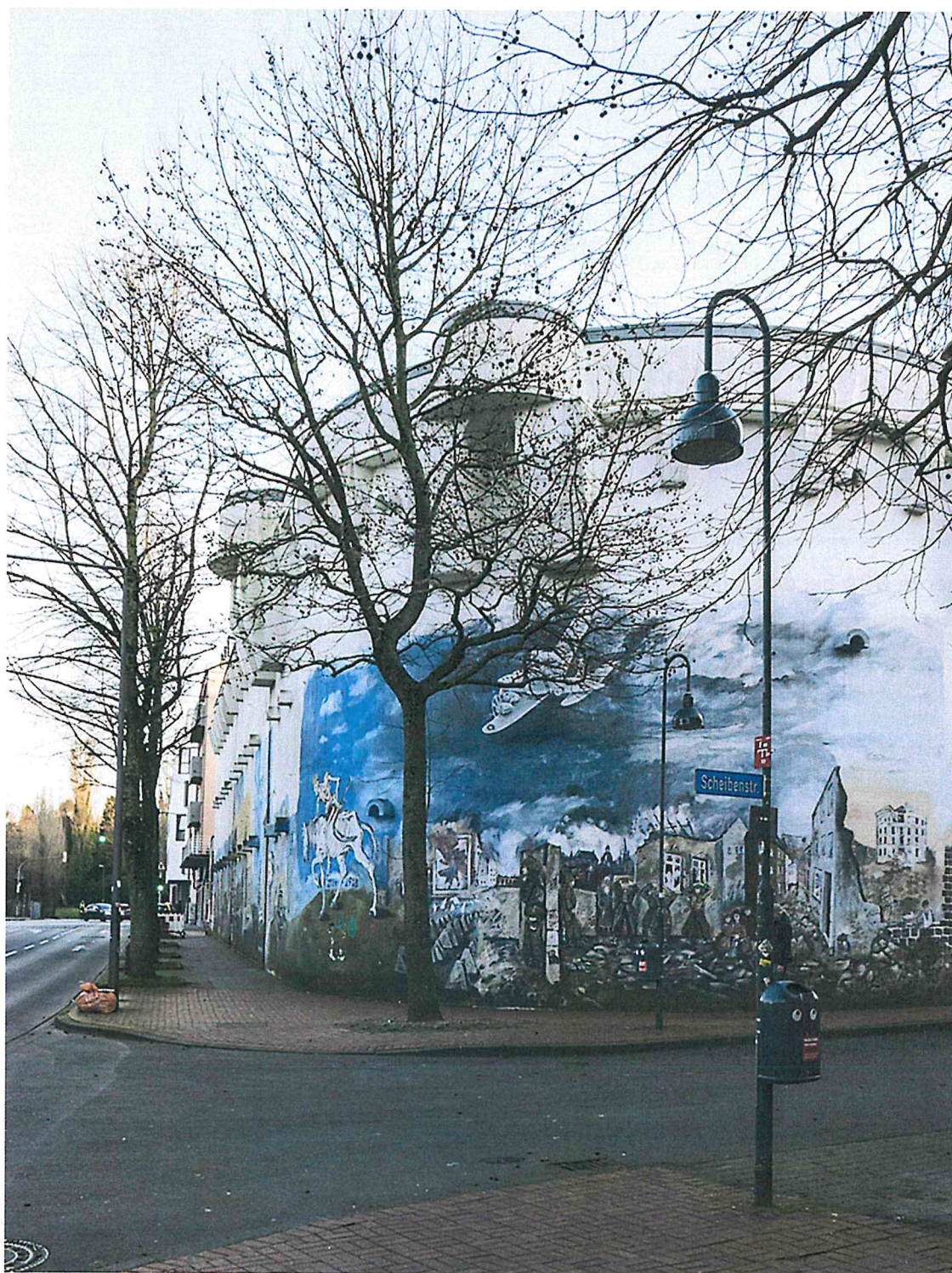
Hochbunker Scheibenstraße – Außenfassade
