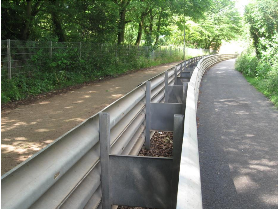
Während der Baumaßnahme Zeelink und Amprion
