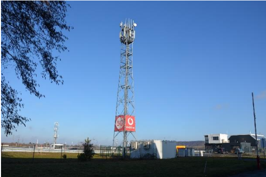
5 G-Technologie auf dem campus aldenhoven (Future Mobility Park) als Voraussetzung für Fahrversuche zum autonomen Fahren (Quelle: cima (2020))
