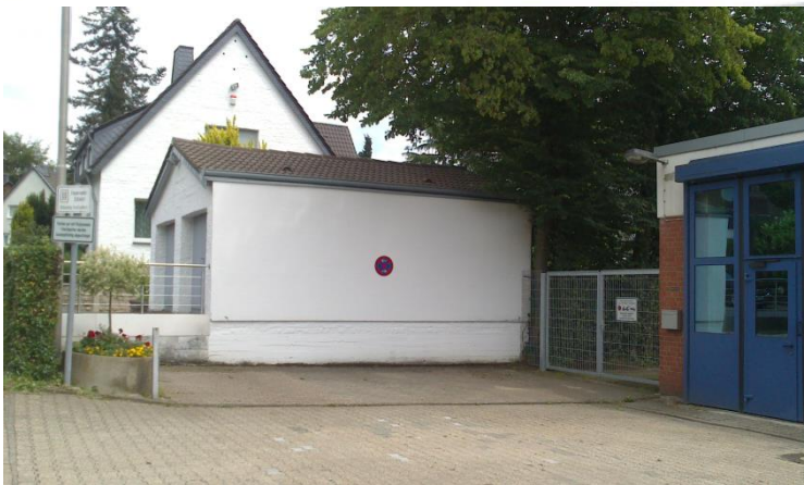
Feuerwehr Fahrzeughalle und Nachbarbebauung.
