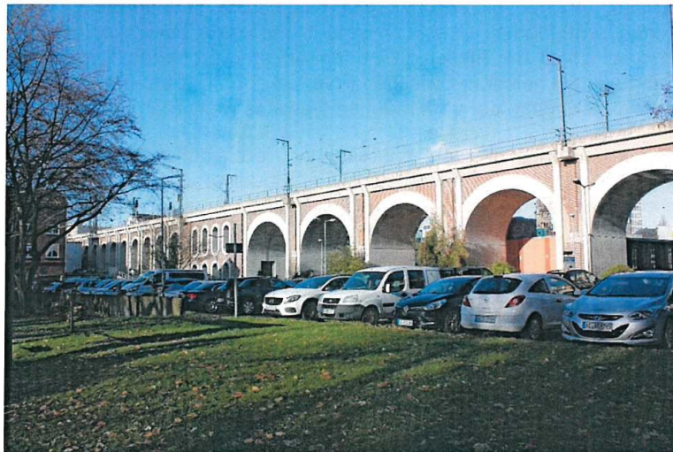
Abb. 04 Aktuelle Ansicht auf den Eisenbahnviadukt von Burtscheid
