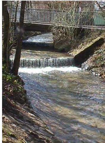
Brückenbauwerk Friesenrather Straße und Staustufe in der Inde, Foto: UWB Stadt Aachen
