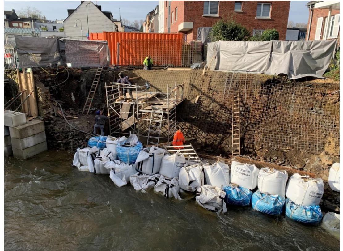
Sicherung der Böschung mit Erdankern und nachfolgender Spritzbetonschale
