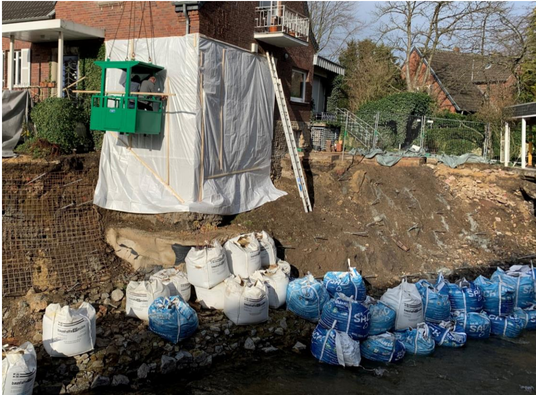
Sicherung der Uferlinie mit Big Bags
