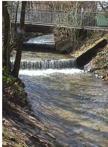
Brückenbauwerk Friesenrather Straße und Staustufe in der Inde, Foto: UWB Stadt Aachen
