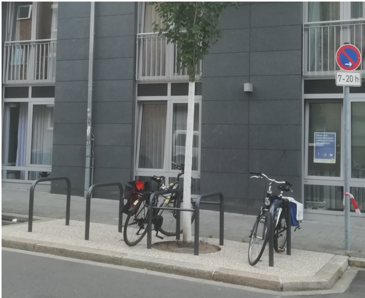
Beispiel eines neuen Baumstandorts mit Fahrradbügeln; PU-gebundener, wasser- und luftdurchlässiger Belag
