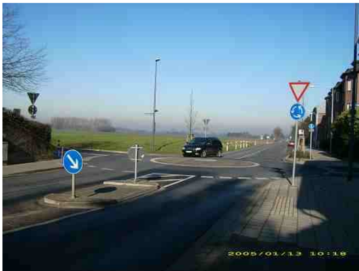
Kreisverkehr Horbacher Straße/Bankerfeldstraße
