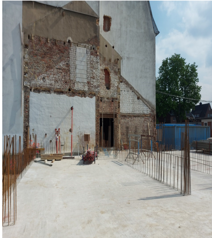
Baustellenfotos Bauteil B
