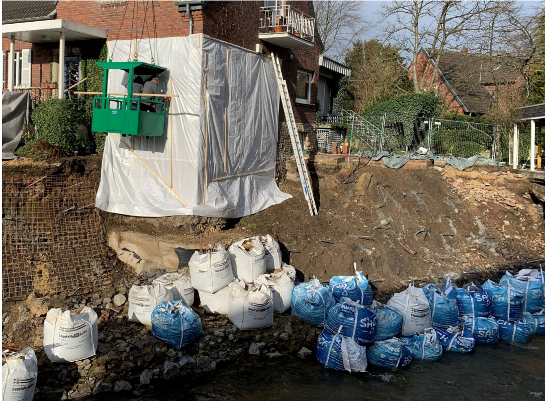
Sicherung der Uferlinie mit Big Bags
