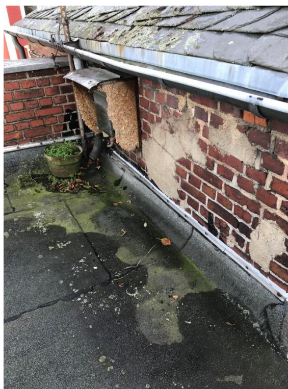
Anschluss Treppenturm / Flachdach
