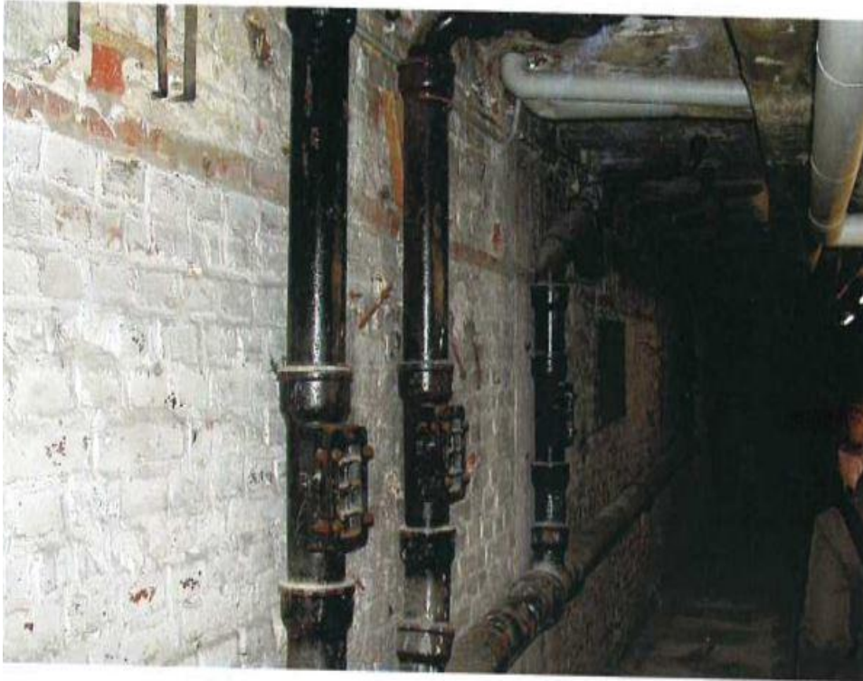
Alte Gussrohrenentwässerungsleitungen
