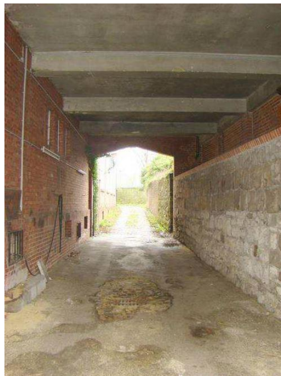
Rückseitige Fassaden der Turnhalle
