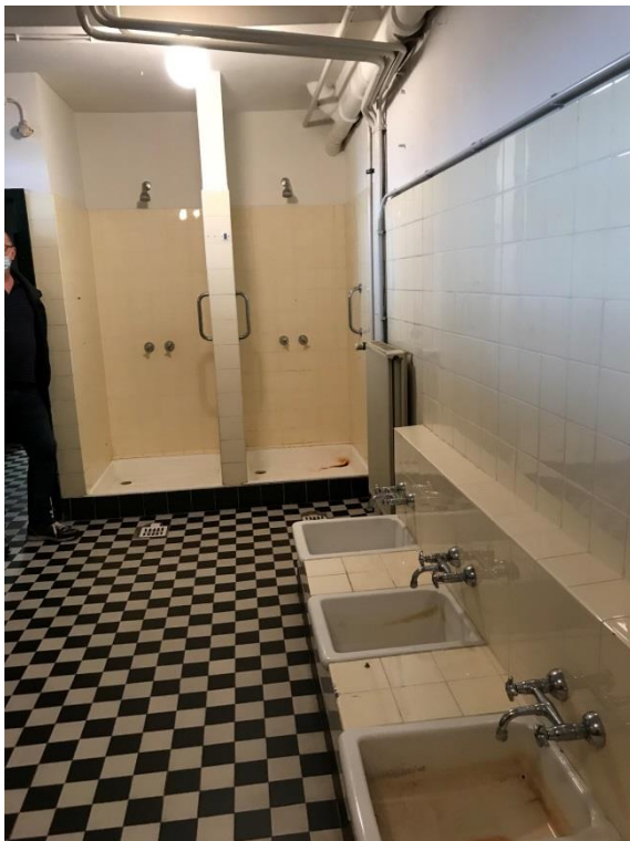
Sanitärbereiche Damen im Erdgeschoss
