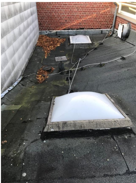
Oberlichter Flachdach Nebenräume
