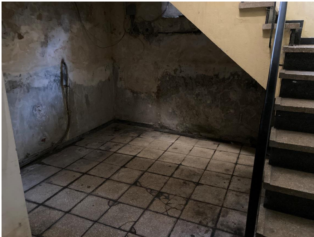
Außenwand Treppenraum im Untergeschoss
