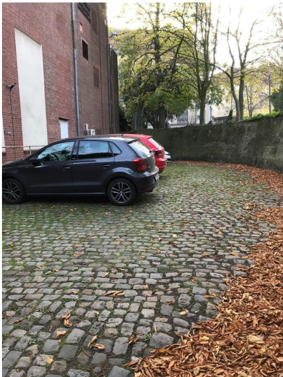
Kopfplastersteine im Bereich der Parkplätze
