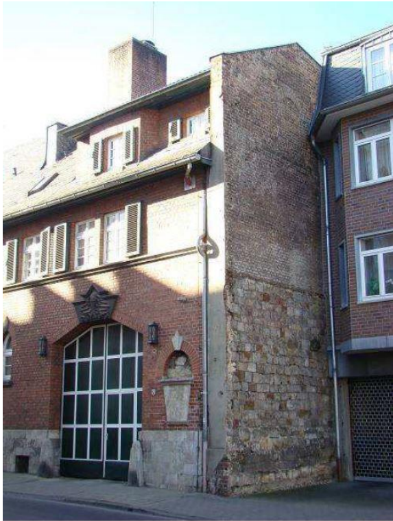
Giebelwand „Seilgraben“ auf Barbarossamauer
