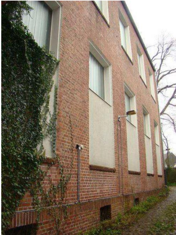
Nordfassade Hallenbereich (Innenhof)
