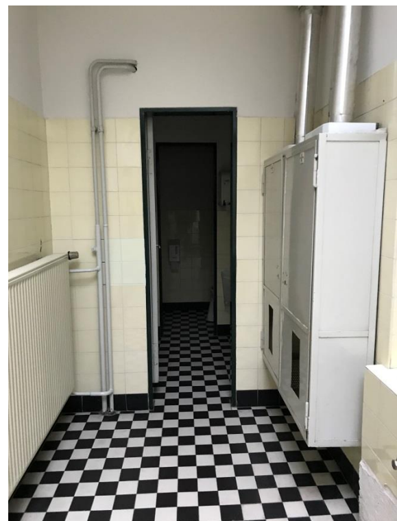
Sanitärbereiche Damen im 2. Obergeschoss
