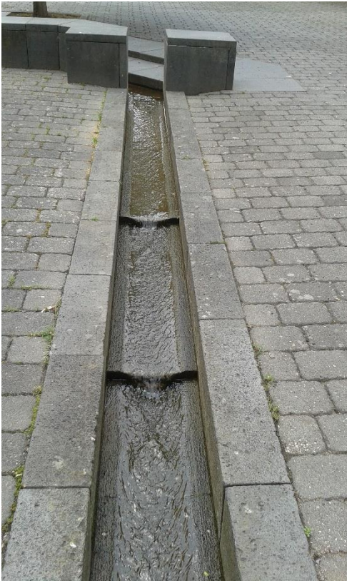
Abbildung 6: Bachgerinne mit Sohlabstürzen in Mayen
