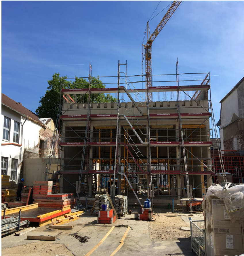
Baustellenfotos Bauteil B
