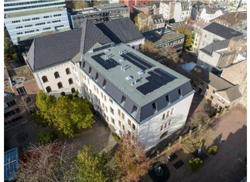
Kaiser- Karls- Gymnasium Dach 3 mit 29 kWp
