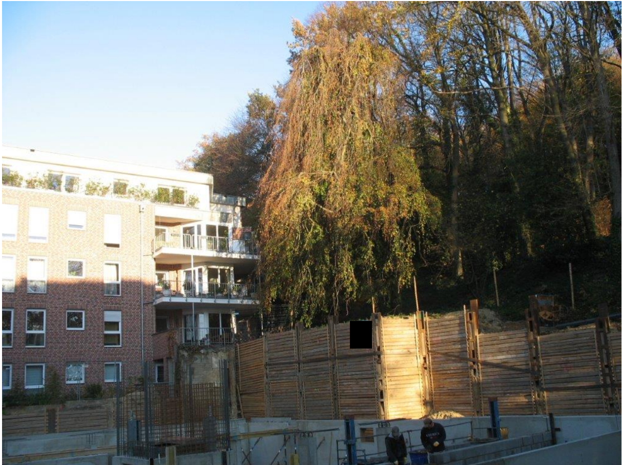
Abbildung 6: Fachliche Begleitung mit ÖBB im Rahmen der Erstellung eines baumnahen Gradverbaus in Hanglage; .
