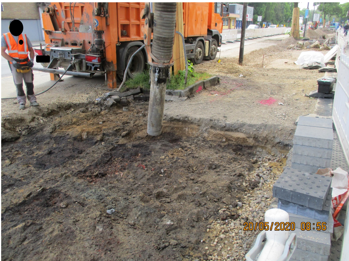
Abbildung 2: Das vorsichtige Freilegen und Dokumentieren von Wurzeln bei einer Wegsanierung. Eine fachliche Tätigkeit der ÖBB, um die Verkehrssicherheit des Baumes zu dokumentieren und Folgeschäden durch die Baumaßnahme zu verhindern.
