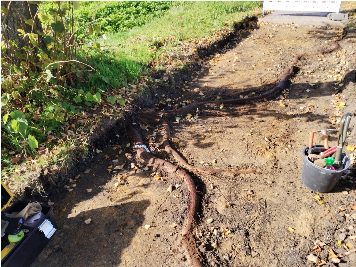
Abbildung 2: Das vorsichtige Freilegen und Dokumentieren von Wurzeln bei einer Wegsanierung. Eine fachliche Tätigkeit der ÖBB, um die Verkehrssicherheit des Baumes zu dokumentieren und Folgeschäden durch die Baumaßnahme zu verhindern.
