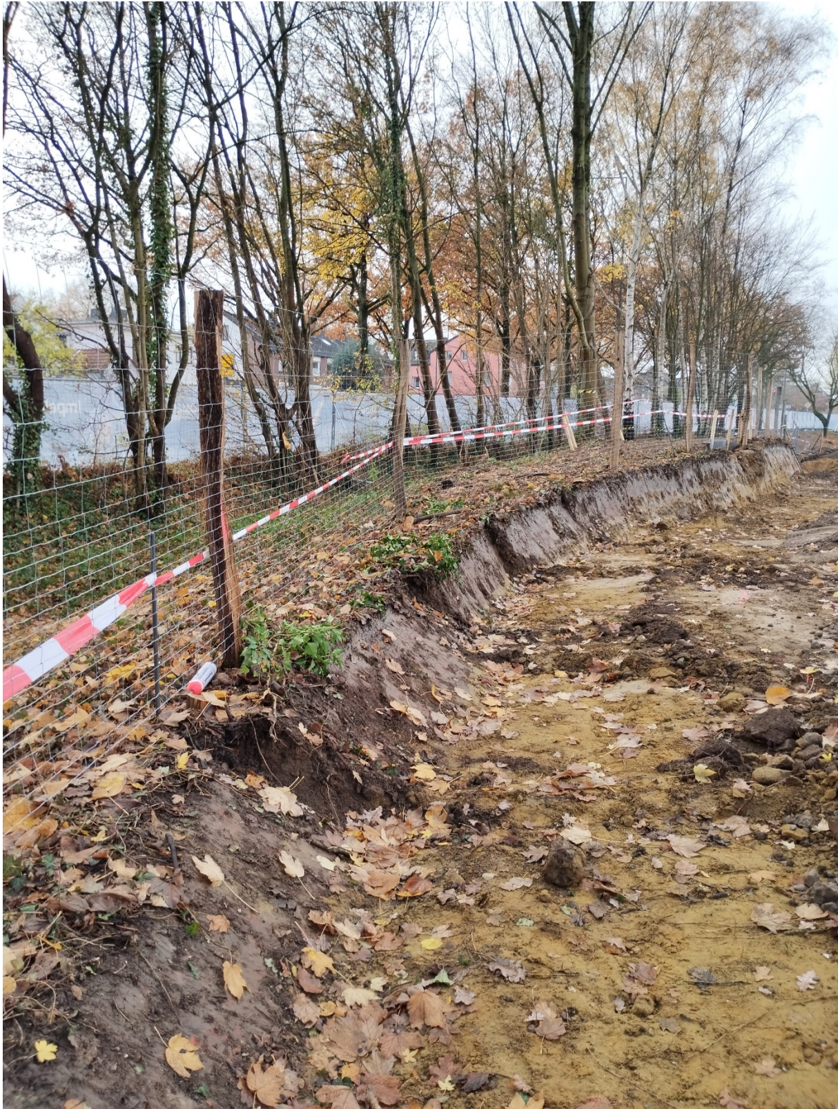
Abbildung 1: Durchgängiger ortsfester Zaun zum Schutz des Baumbestands, hier bedarf es keiner ÖBB.
