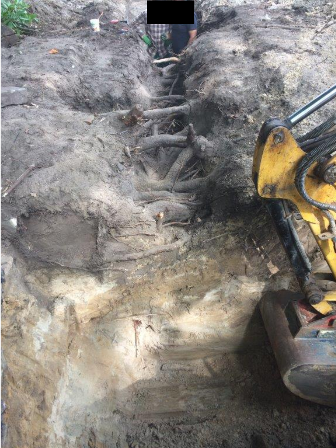
Abbildung 5: Fachliche Unterstützung bei Erdarbeiten im Wurzelhorizont wertvoller Bäume; Baubegleitung zielführend.
