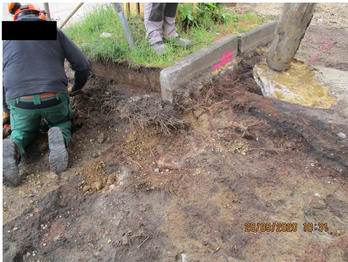
Abbildung 4: Das in Handarbeit freigelegte Wurzelwerk wird für die weitere Baumaßnahmen geschützt; der Baum profitiert und kann sich in Zukunft deutlich besser entwickeln.
