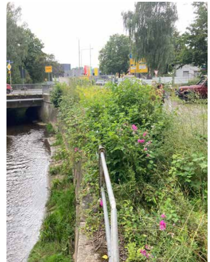
Mauereinfassung Wurm Blick Richtung Kreuzung Alt-Haarener-Straße/Wurmbenden
