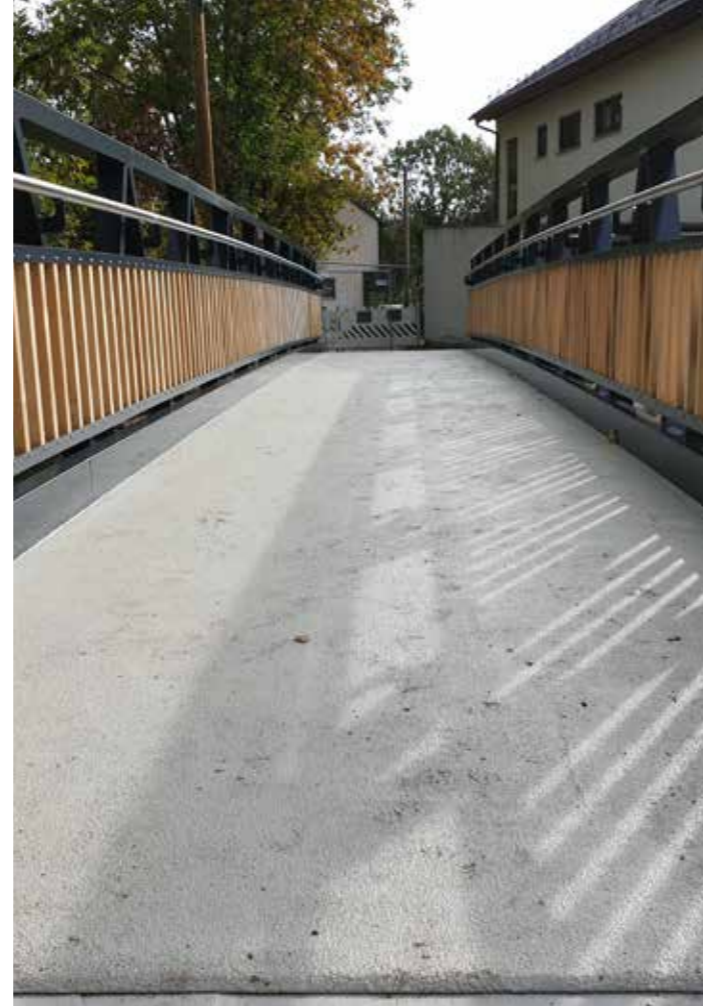
Belag Brückenbelag aus Aluminiumplatte mit RHD-Belag R12/13
