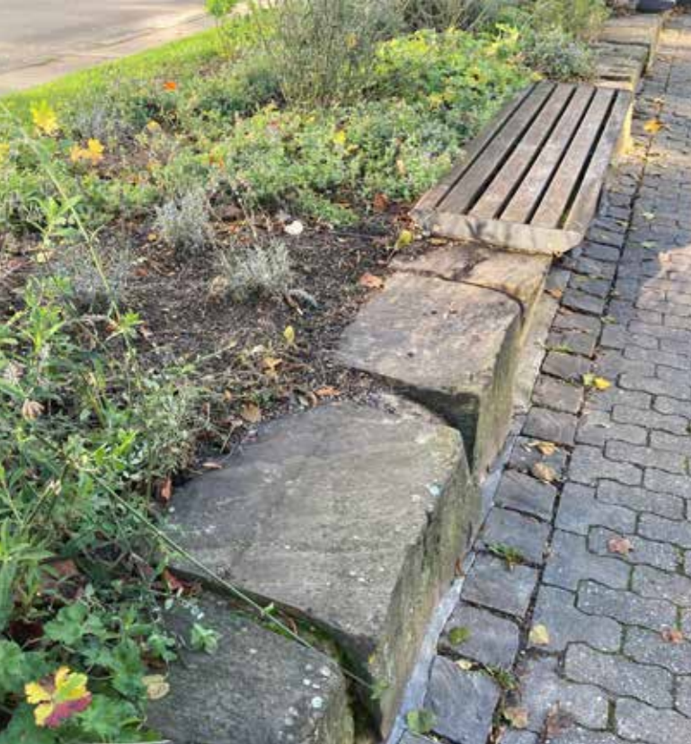
Blocksteinmauer, Beispielfoto Frankenberger Park Natursteinblöcke Grauwacke, verschiedene Maße unterschiedliche Einbauhöhen, z.T mit Holzauflage
