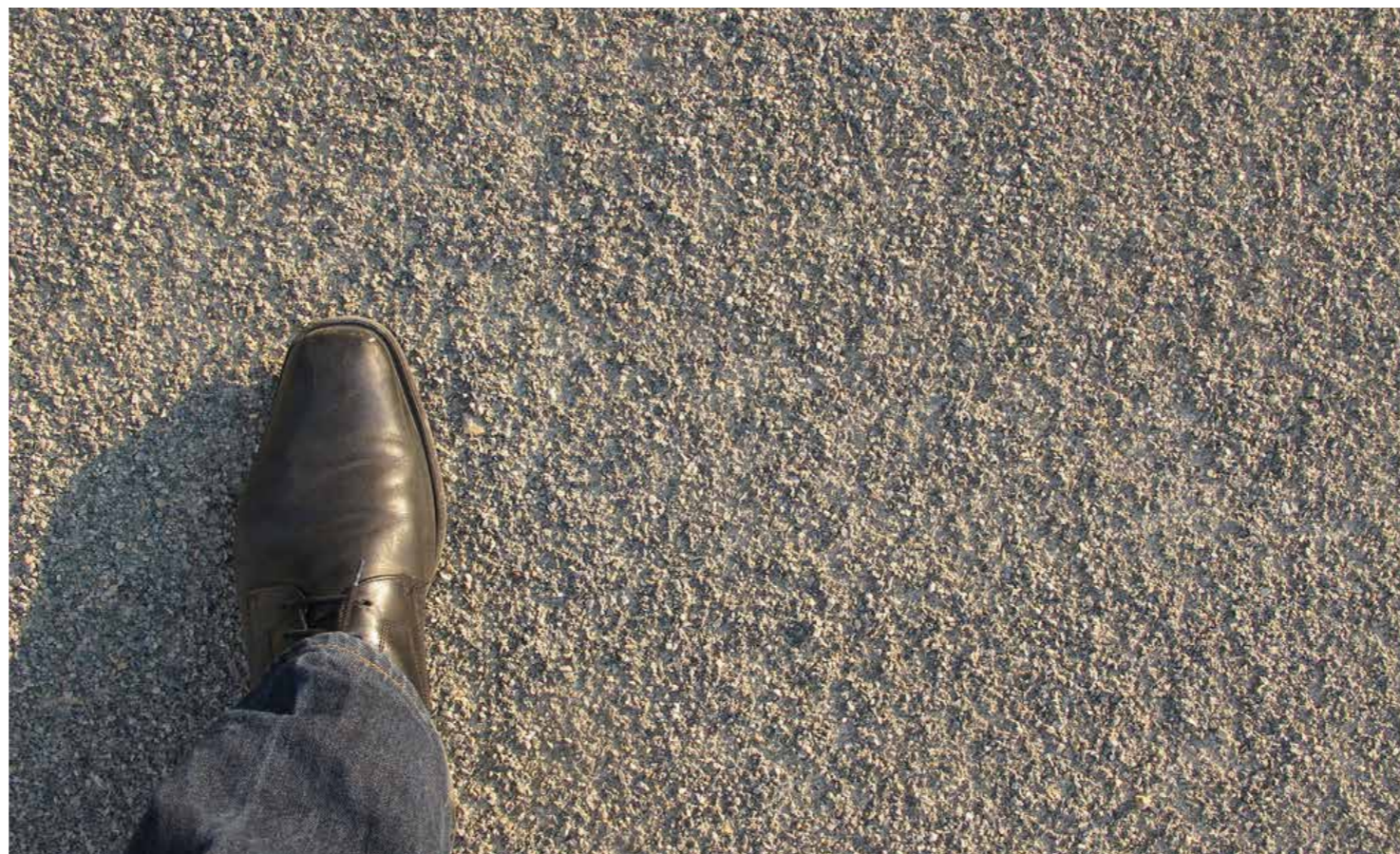
Wassergebunde Wegedecke Kalksteinsplitt (grau/braun)
