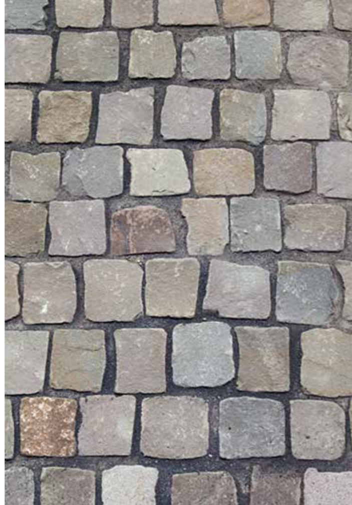
Kleinsteinpflaster Grauwacke Für die Eingangsflächen, an den Eckpunkten
