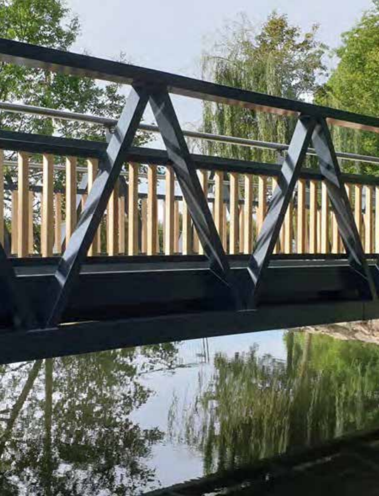
Fuß- und Radwegbrücken aus Aluminium
