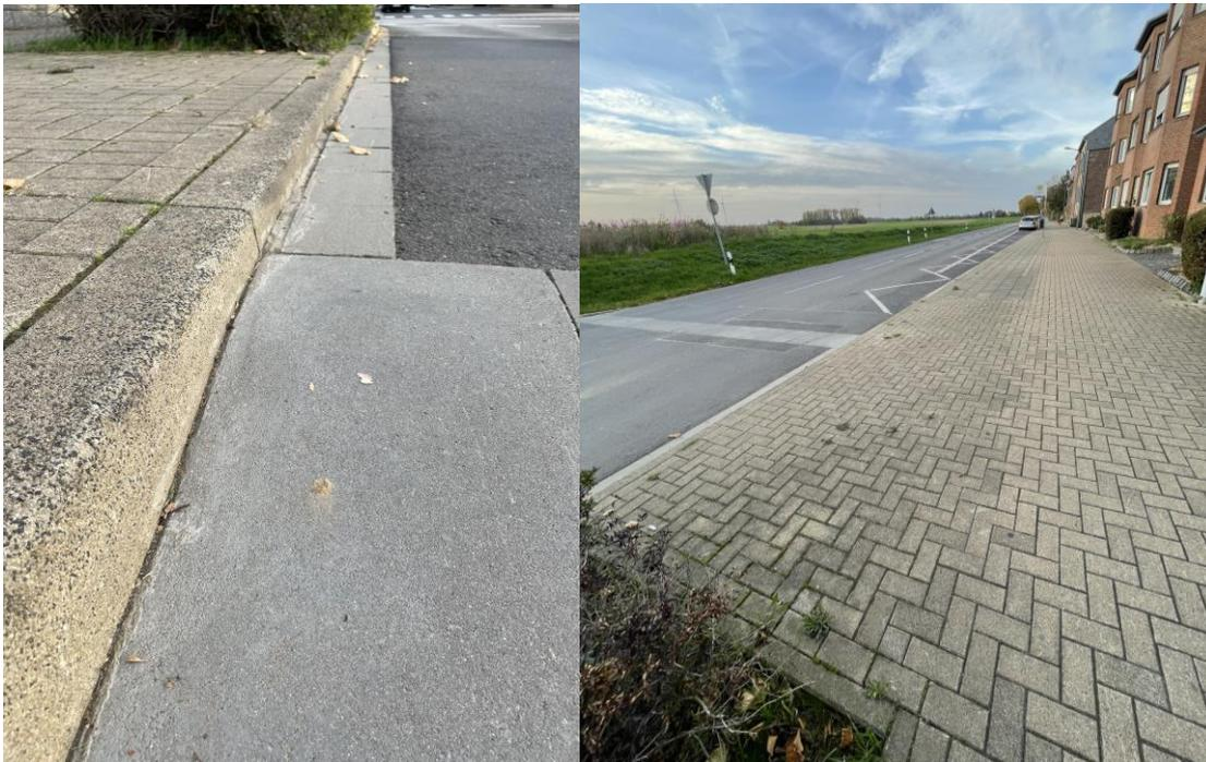
Abb. 2 und 3: Horbacher Straße in Alt-Richterich – Anrampung für die Querung des Radverkehr, Höhenunterschied und potentielle Aufstellfläche, Blickrichtung in Richtung Horbach
