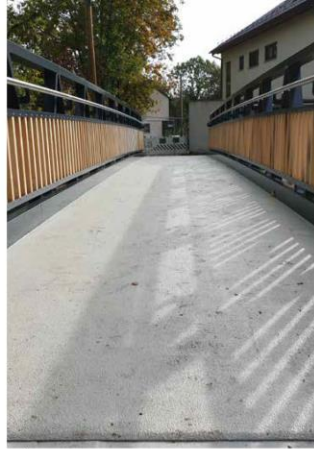
Belag Brückenbelag aus Aluminiumplattform mit RHD-Belag R12/13
