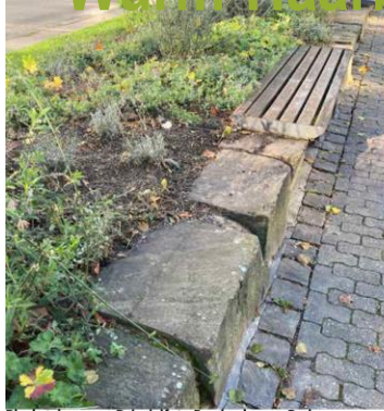
Blocksteinmauer, Beispielfoto Frankenberger Park Natursteinblöcke Grauwacke, verschiedene Maße unterschiedliche Einbauhöhen, z.T mit Holzauflege
