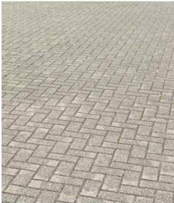
Bestandspflaster Tuchmacherweg, Zugang Laachgasse
