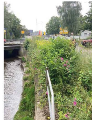
Mauereinfassung Wurm Blick Richtung Kreuzung Alt-Haarener-Straße/Wurmbenden
