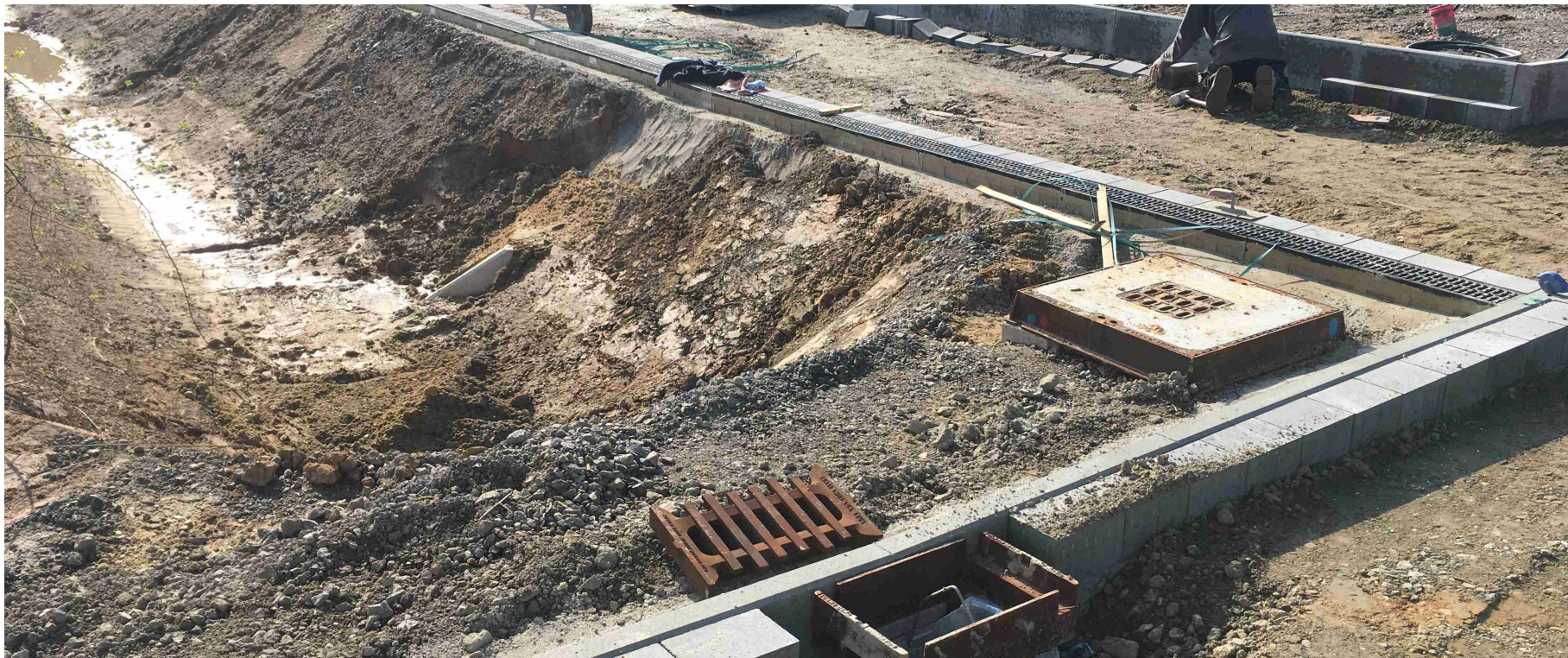
Fertigstellung 2023, Bezirk Mitte, Skatepark Eisenbahnweg, Tiefbauarbeiten
