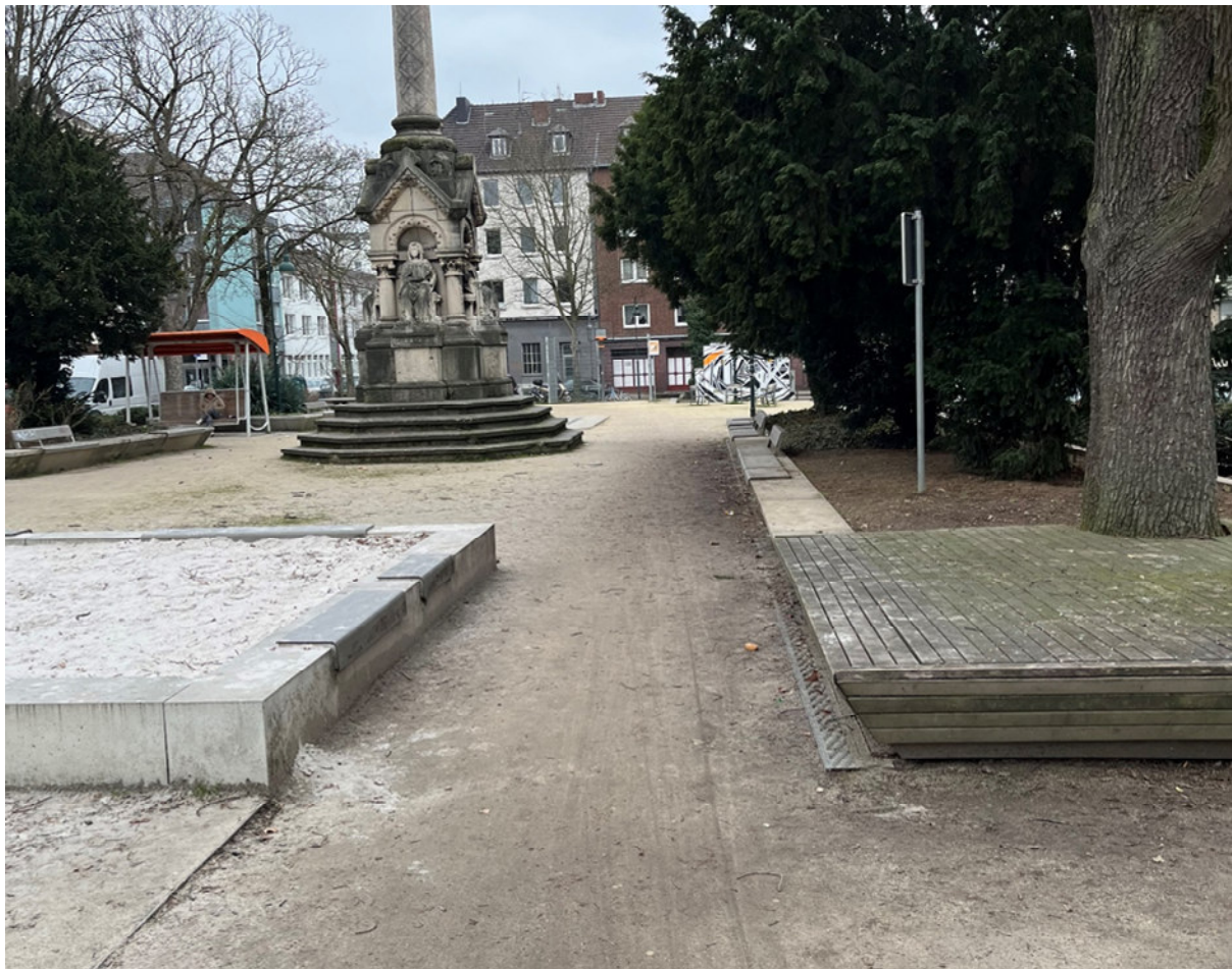
Abbildung 13 Wassergebundene Wegedecke Rehmpplatz, eingeschränkte Barrierefreiheit
