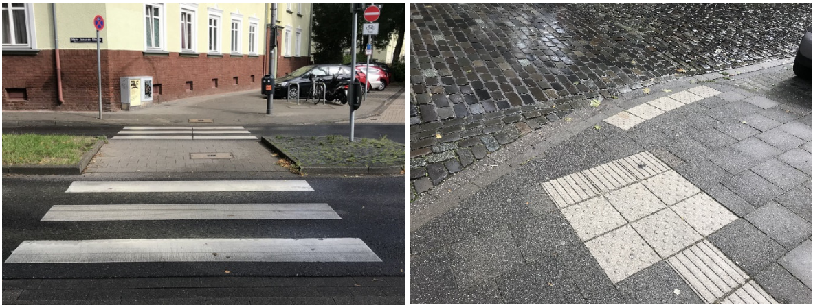
Abbildung 5: Querungshilfe ohne (Hein-Janssen-Straße, links) und mit barrierefreier Ausstattung (Rehmplatz, rechts)
