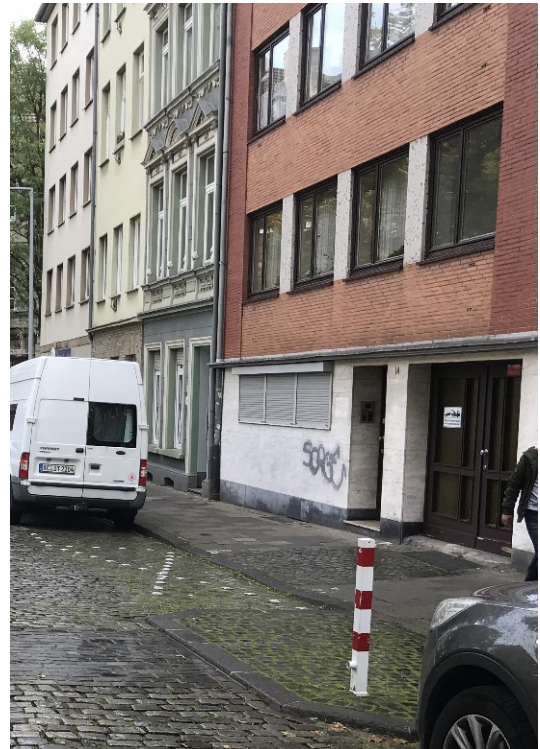
Abbildung 11: Querneigung und Gehwegabsenkung am Rehmplatz
