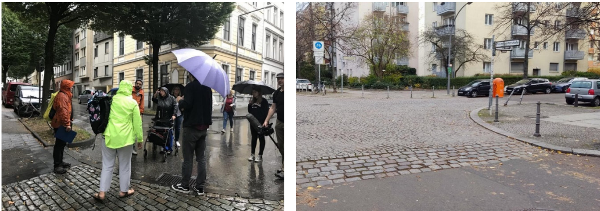
Abbildung 7: Scharfer Kurvenbereich Johanniter-/Paulusstraße (links) und Beispiel einer Anhebung durch Aufpflasterung eines Kreuzungsbereichs in Prinzregentenstraße, Berlin (rechts)
