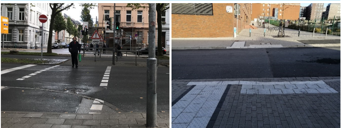
Abbildung 4: Beispiel fehlender differenzierter Bordhöhe (links) und Nullabsenkung mit Hochbord (rechts)
