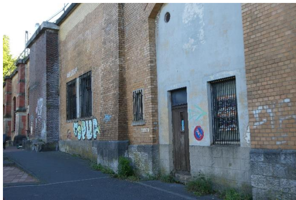
Bild 23 Heute als Probenraum genutzter Bereich
