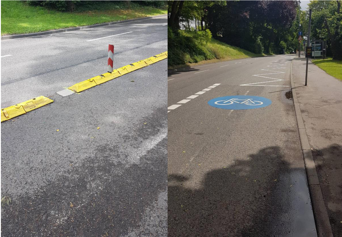
Saarstraße: temporäre Führung, Leitschwellen mit Mini-Baken für die Protected Bike Lane
