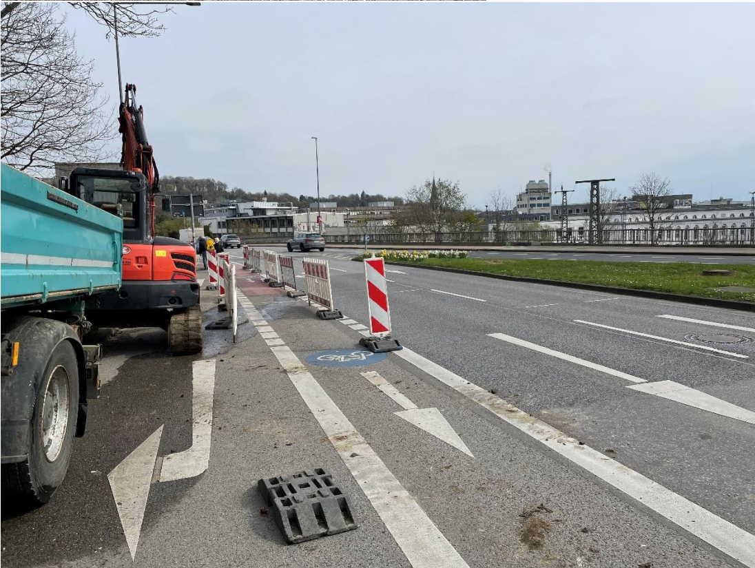
Abb. 5: Brücke Turmstraße, vor dem Abriss | April 2022
