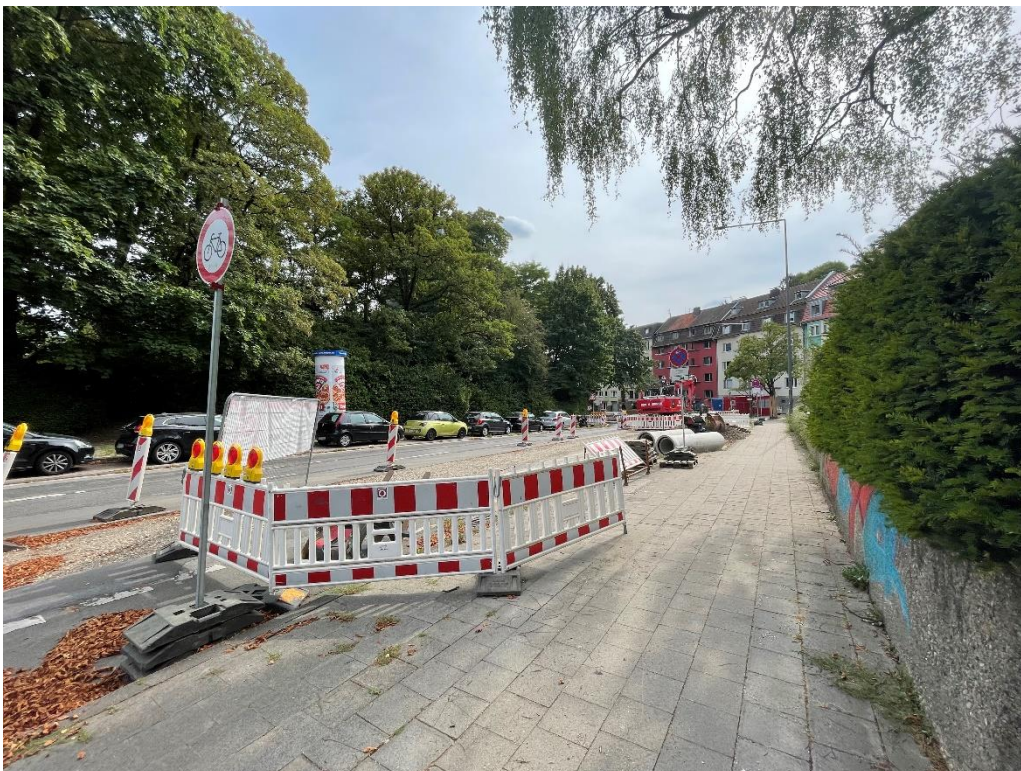
Abb. 9: Turmstraße, Einmündung Melatener Straße in Blickrichtung Maastrichter Straße während der Bauarbeiten | August 2022
