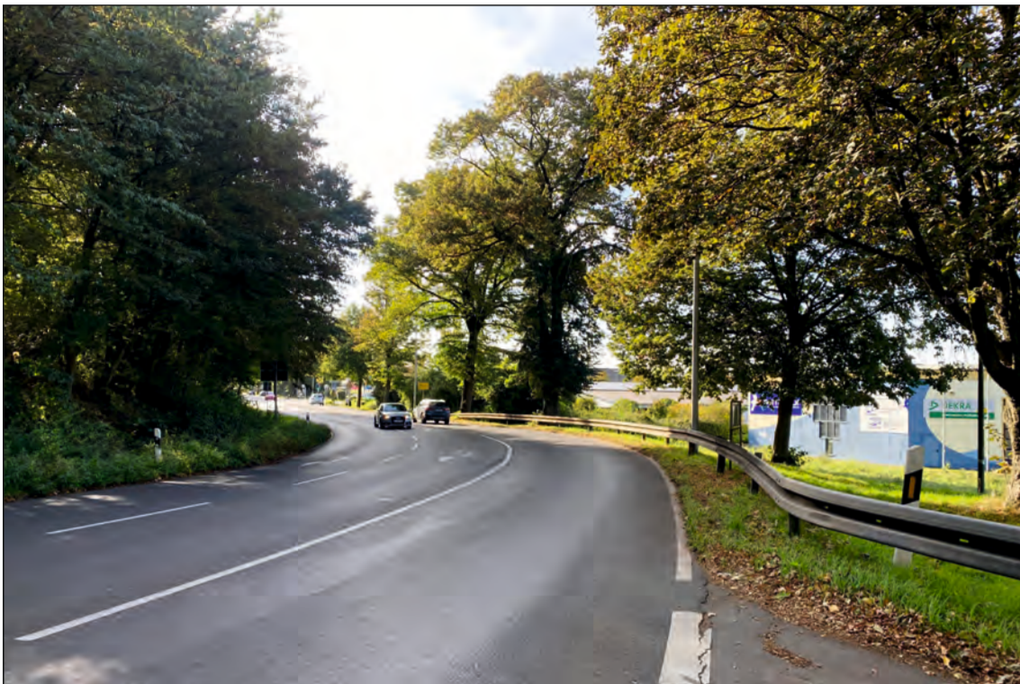
1) Roermonder Straße, Blick in Richtung Richterich
