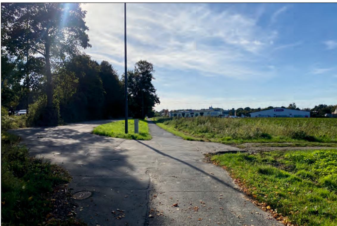
2) Teilstück „Alte Roermonder Straße“ und Radweg, Blick Richtung Gewerbegebiet Roder Weg
