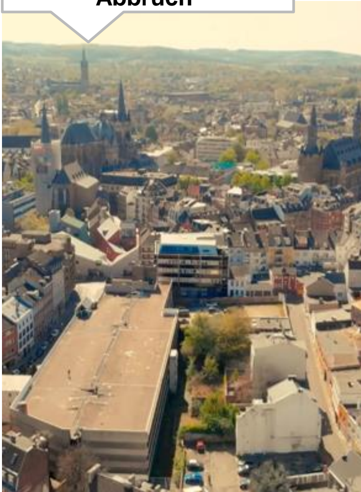
Parkhaus vor dem Abbruch
